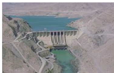
بند برق نغلو
